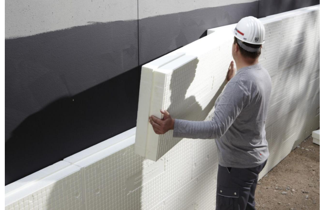
Abb. 13: Perimeter- dämmung aus EPS-Hartschaum
