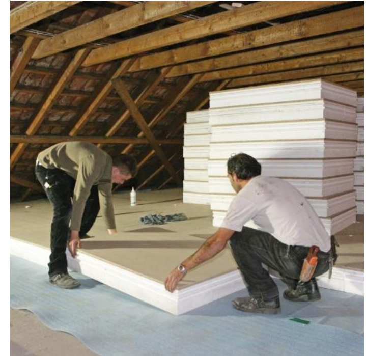
Abb. 12: Dämmung der obersten Geschossdecke mit begehbaren EPS-Verbundelementen
