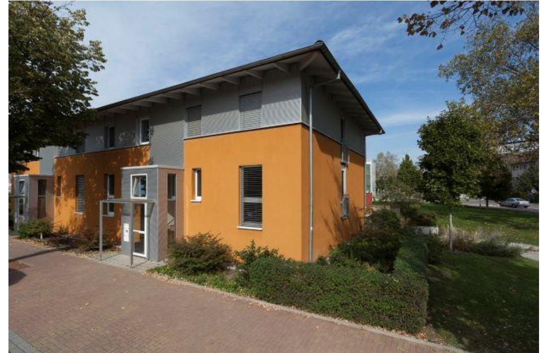
Abb. 10: Wohnhaus mit Wärmedämm-Verbundsystem als Fassadendämmung
