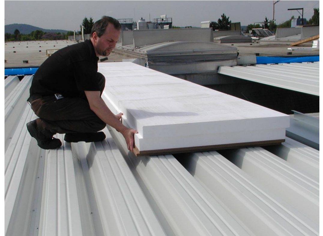
Abb. 7: Industrielichtdach mit EPS-Flachdachdämmung
