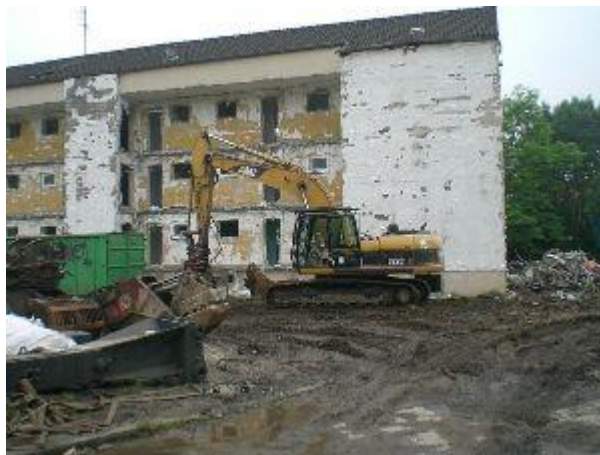
Abbildung 62: Abbruch Übergangswohnheim Dortmund 2009 Quelle: Carsten Hörde mann http://forum.bauforum24.biz
