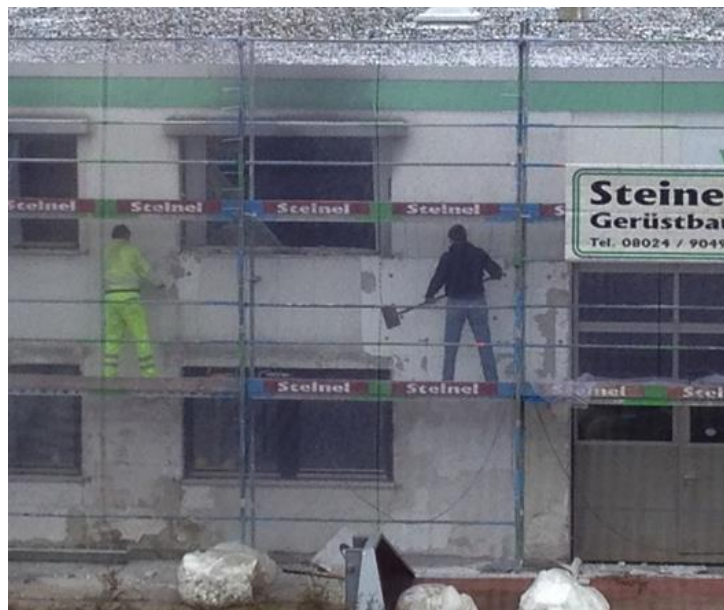
Abbildung 64: Entfernen der EPS-Platten mit einem Eisschaber. Die Dübelschäfte werden mit einem Bohrhämmer mit Meißel gelockert und von Hand herausgezogen (Quelle: FIW München)
