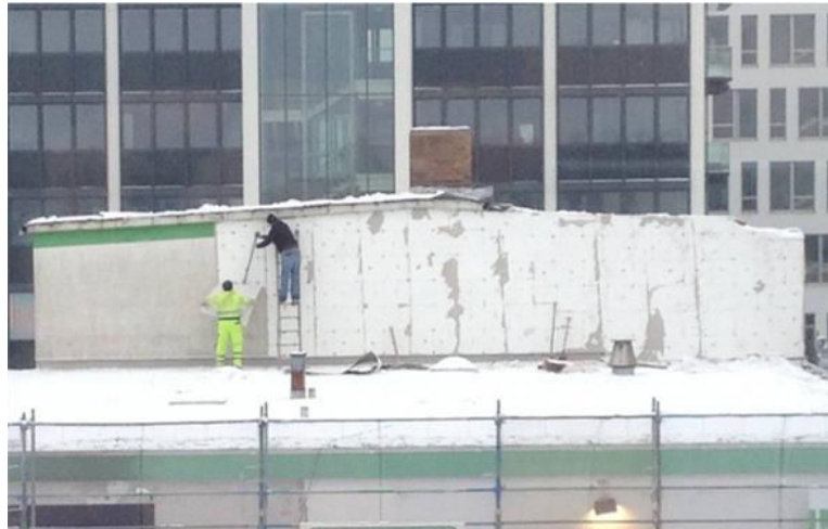
Abbildung 63: Abschälen der Putzschicht mit einem Eisschaber, Gräffeling 2013 (Quelle: FIW München)
