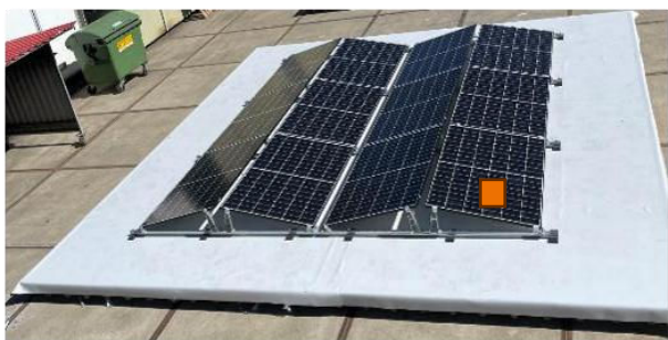
Prüffeld mit Gasbrennerposition (orange) zwischen PV-Modul und Abdichtungsbahn
